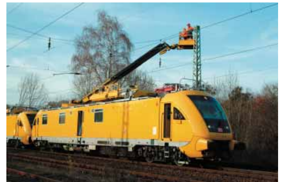
2 Modernes Instandhaltungsfahrzeug, gebaut in Kirchmöser
